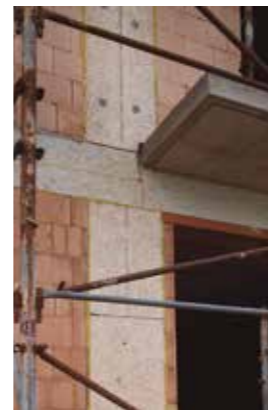
Eliminación de puentes térmicos.
