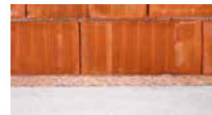
Los tabiques se levantan sobre una tira de Celenit N de 25 mm.
