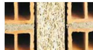
La separación entre paredes debe ser ligeramente superior al espesor del panel, para que éste pueda vibrar.
