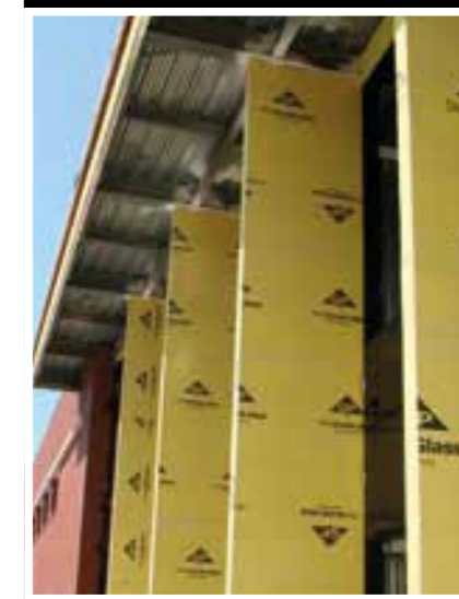
COLUMNAS Y VIGAS
