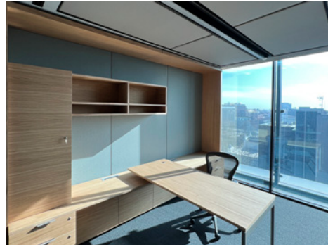
Panelado pared y techo.
