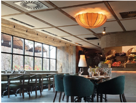
Panelado techo biselado.
